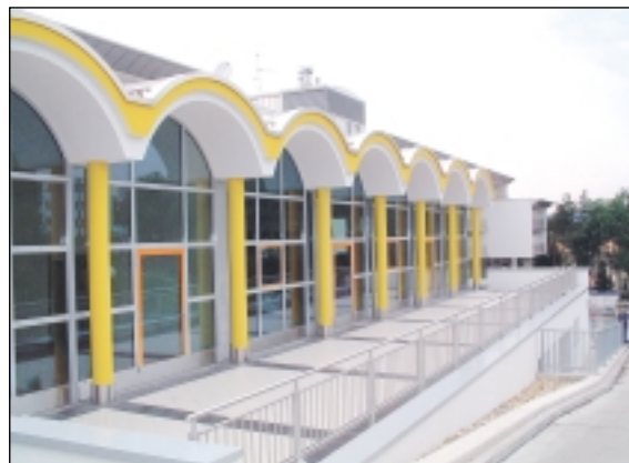
Das NRZ Rosenhügel – hier die Ansicht der Terrasse – befindet sich unmittelbar neben dem Neurologischen Krankenhaus der Stadt Wien
